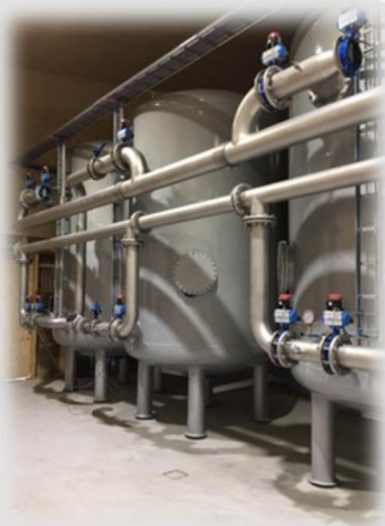
Foto interiør vandværk: Filtre
